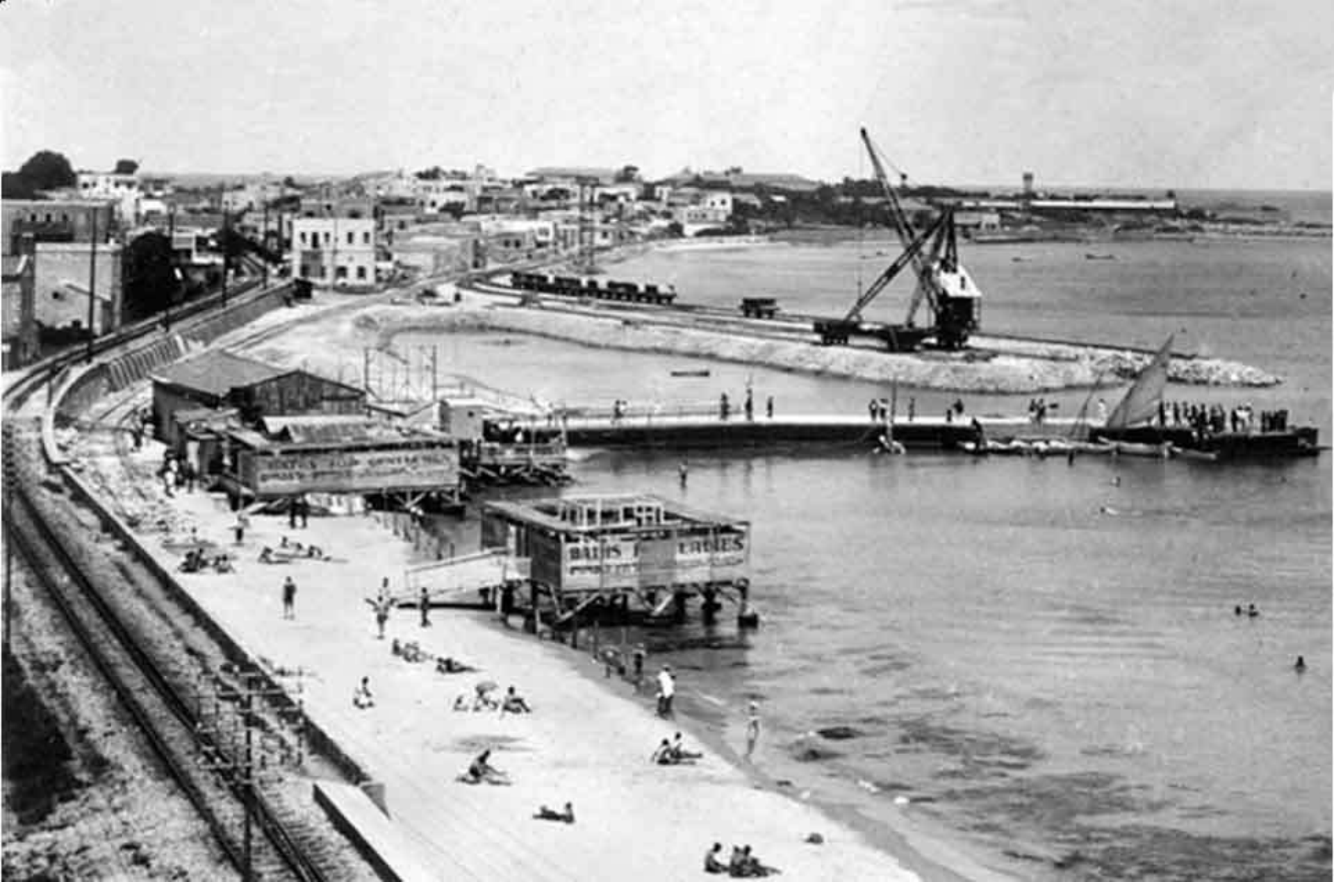
התחלת בניית חומת הרציף בצידו הדרומי של המעגן. בתצלום נראים גם "המזח הגרמני" וגם חוף הרחצה של חיפה, שנועדו להיעלם מהעין, עם ייבוש קטע זה של הים.
