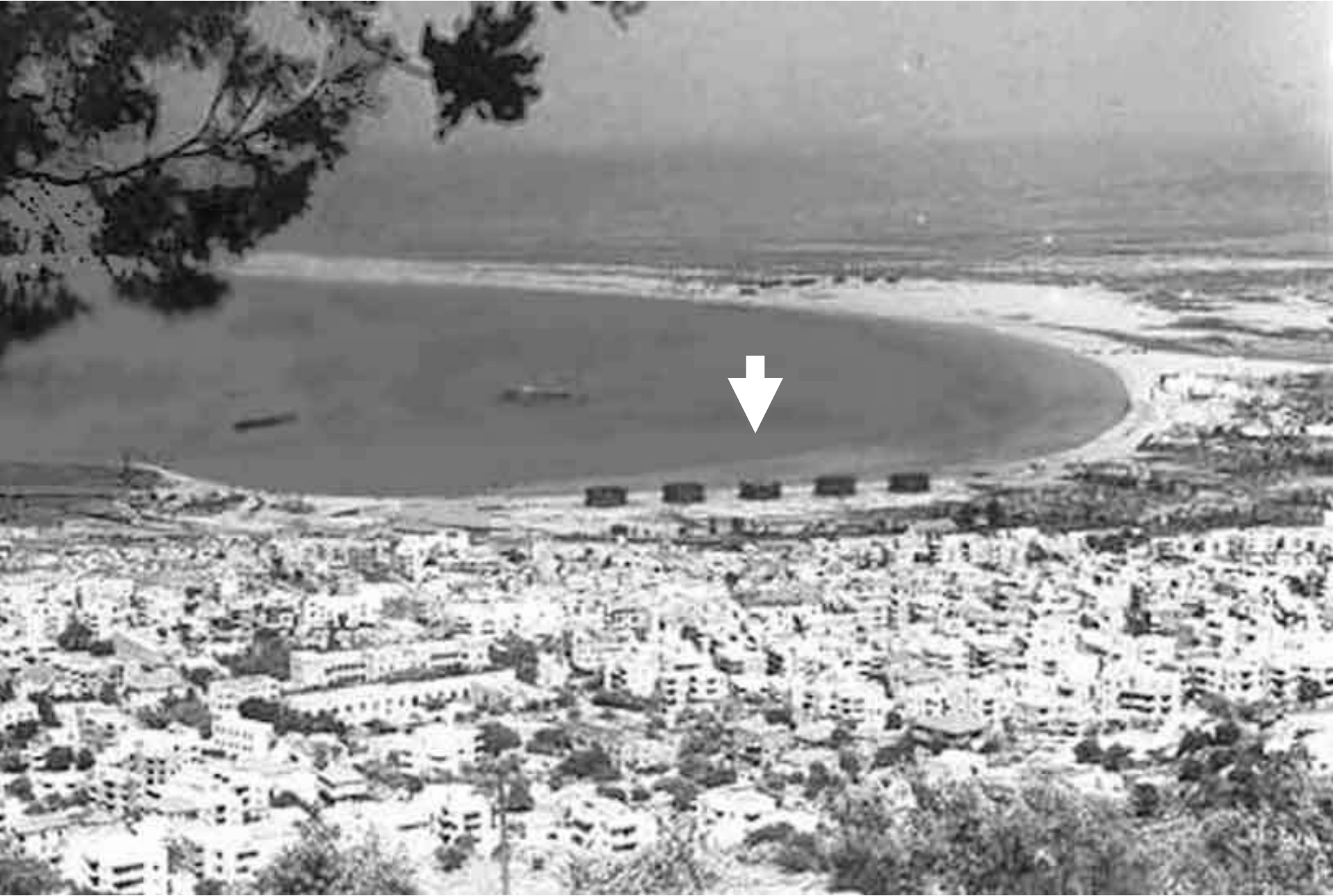
ב-1938, לקראת תחילת הפעלתם של בתי הזיקוק, הוקמו בחוף המפרץ, מחוץ למעגן הנמל, חמישה מיכלי ענק (מסומנים בחץ). במיכלים אלה נאגרו תזקיקי הנפט לקראת הובלתם באוניות-מיכל לחו"ל.
