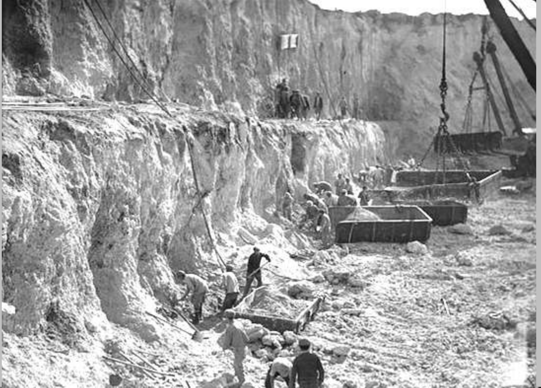
הסלעים שנועדו לבניית שוברי הגלים נחצבו בצלע רכס הכרמל בעתלית והועברו משם ברכבות אל הנמל המתהווה. בתצלום: חציבת האבן בעיצומה, במחצבת עתלית.
