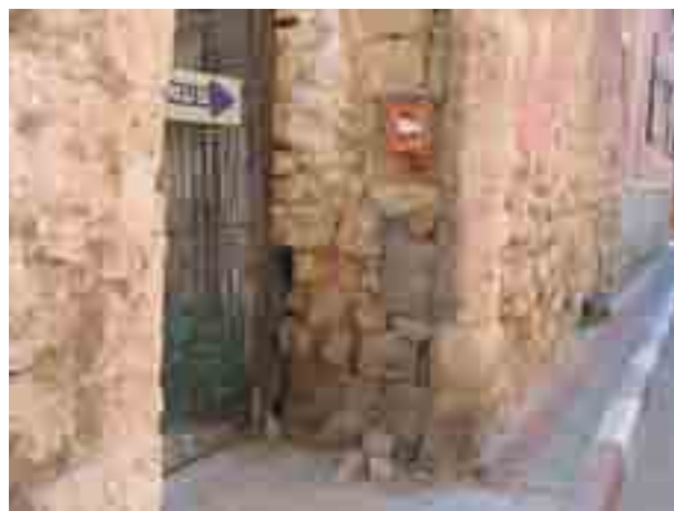
קילופי טיח שחושפים את אבני הכורכר בעיקר משני צידי השער, ובחלקו התחתון של הקיר, כנראה חרף עליית רטיבות מהקרע.
