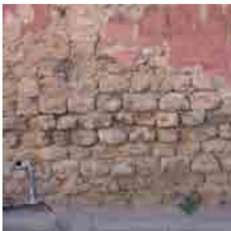
קילופי טיח שחושפים את אבני הכורכר בעיקר משני צידי השער, ובחלקו התחתון של הקיר, כנראה חרף עליית רטיבות מהקרע.
