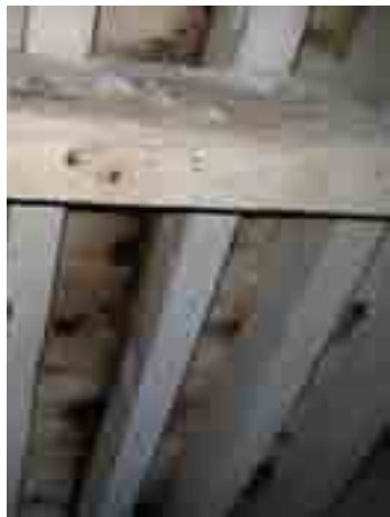
קורות עץ הנושאות את רצפת הקומה הראשונה בבנין ליד הבאר.
