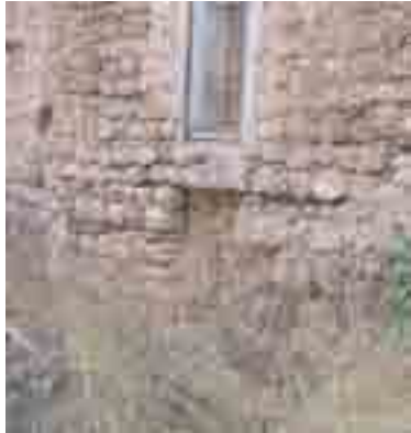
קריסת אבנים מהקיר, העדר טיח שיגן על הקיר גורם לטיט להישטף והינתקות האבנים
