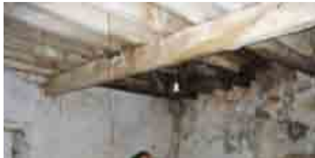
קורות עץ הנושאות את רצפת הקומה הראשונה בבנין ליד הבאר.
