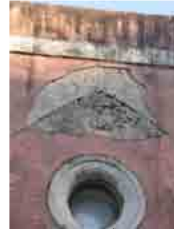
סדקים על בסיס הקמרונות, כתמי רטיבות בחלק העליון
